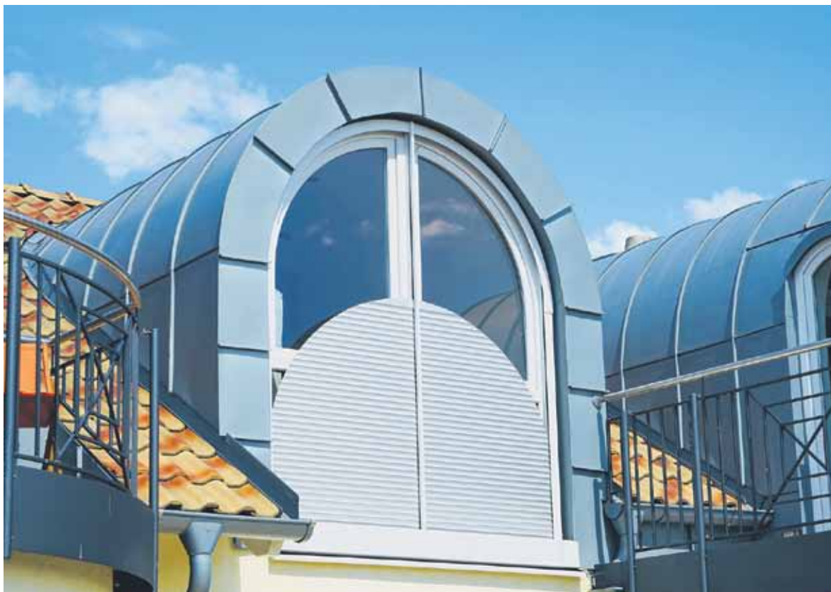
Diese Beschattungslösung schließt sich nahtlos an die extravagante Architektur des Hauses an.
