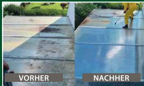
Wir arbeiten mit einem Hochdruckreiniger mit 80% Luft und 20% Wasser.
