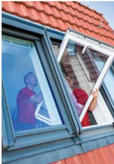
Wird ein Dachfenster eins zu eins ausgetauscht, geht dies binnen weniger Stunden über die Bühne, weil kein großer Eingriff in die Dachstruktur nötig ist.
