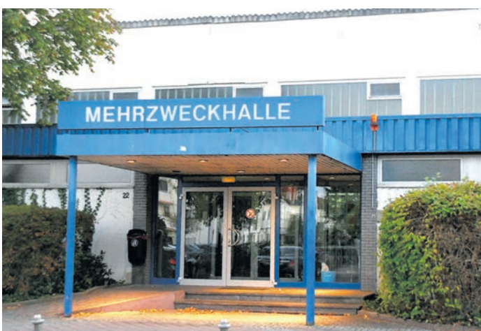
Eppertshäuser Mehrzweckhalle zählt zu den ältesten Sporthallen im Landkreis und soll einem Neubau mit Sportfläche, Mensa und Betreuungsräumen weichen. Nutznießer wäre insbesondere die Stephan-Gruber-Schule. Wann es zur Umsetzung des Großprojekts kommt, bleibt aber weiter abstrakt. (Foto: jedö)
