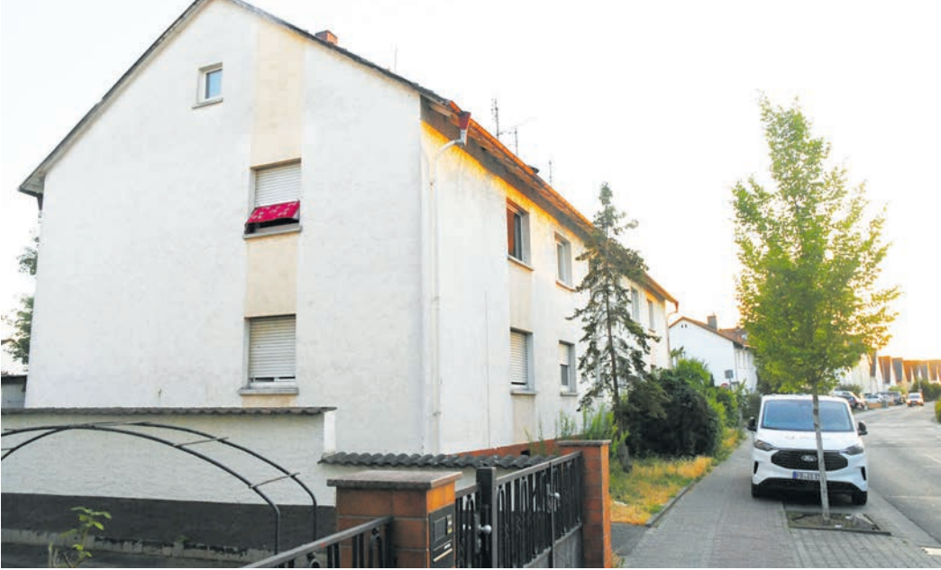
Die gemeindeeigenen Häuser mit den Nummern 154 und 156 in der Goethestraße bleiben erstmal stehen. Für einen Neubau im Rahmen einer Erbpacht-Vergabe hat die Gemeinde Münster keinen adäquaten Investor gefunden. (Foto: jedö)
