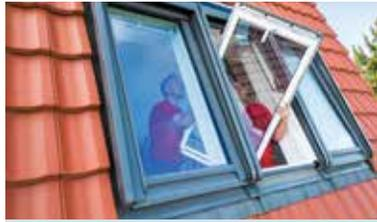
Wird ein Dachfenster eins zu eins ausgetauscht, geht dies binnen weniger Stunden über die Bühne, weil kein großer Eingriff in die Dachstruktur nötig ist.
