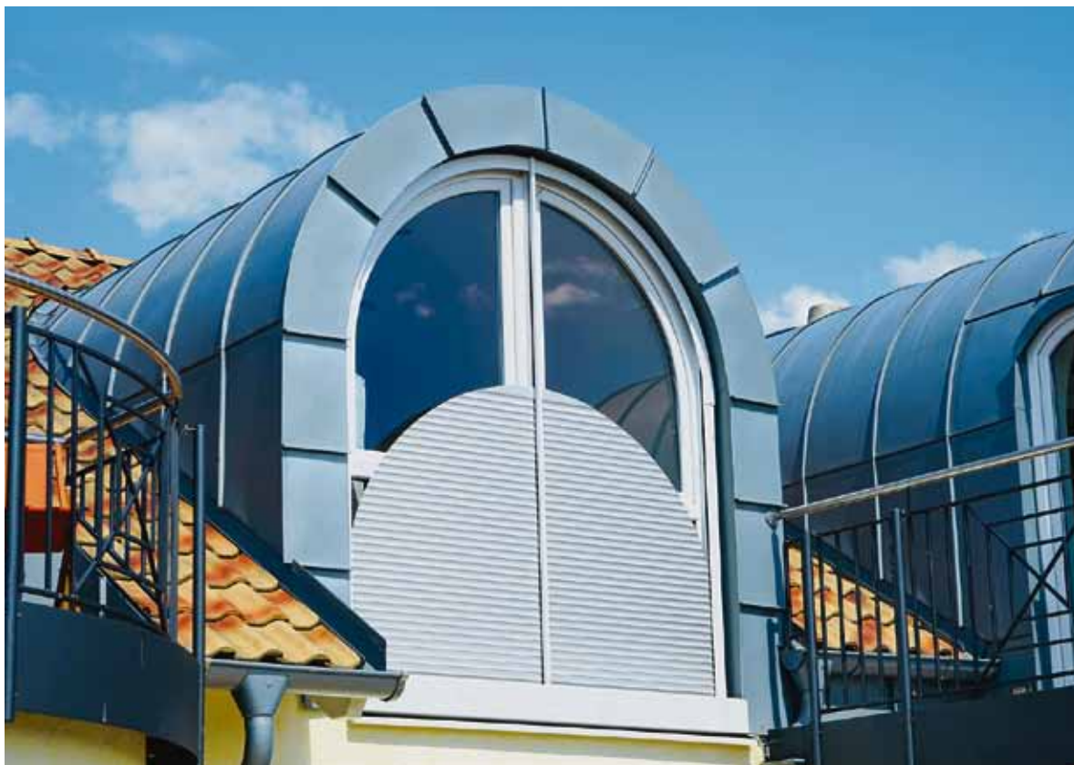
Diese Beschattungsösung schließt sich nahtlos an die extravagante Architektur des Hauses an.
