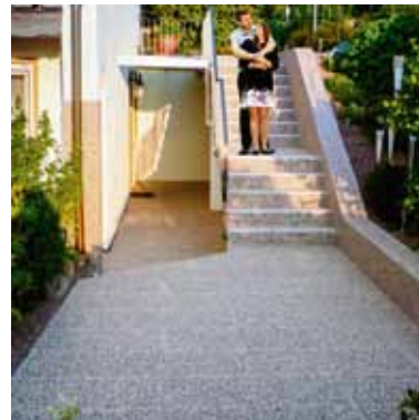
Sicher ist sicher: Eine Modernisierung alter Treppen im Außenbereich reduziert mögliche Unfallgefahren.
