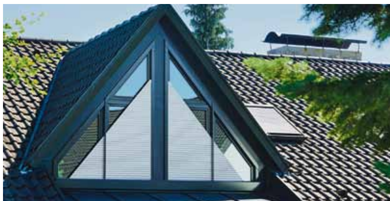
Moderne Rollläden dienen im Sommer vor allem auch im Obergeschoss als Schattensperder - sie können dann aber ebenso beim Energiesparen in der kalten Jahreszeit entscheidend sein.
