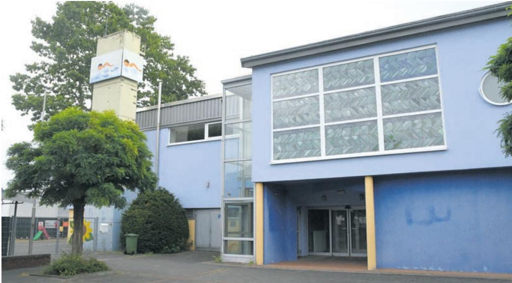
Das Münsterer Hallenbad (links im Bild auch der Eingang zur Kita Sonnenblume, die dort einquartiert ist) ist seit 2019 geschlossen. Verkauf und Art Neubebauung des Grundstücks sind auch sieben Jahre später noch immer nicht konkret beschlossen. (Foto: jedö)
