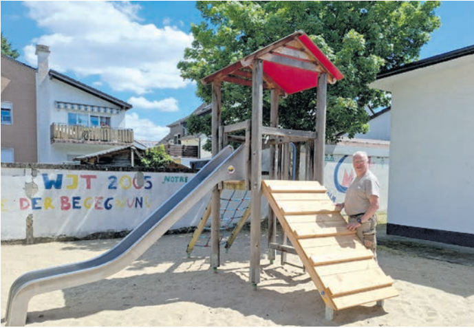
Spielplatzprüfer Martin Bunke und Jens Deckart (nicht auf dem Foto) begutachten die reparierten Teile auf dem Spielplatz Schefflerstraße. (Foto: Regine Dinkelborg/Magistrat)
