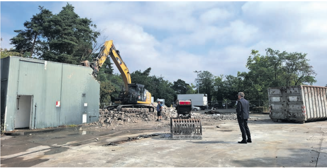
Bürgermeister Steffen Ball beobachtet die Abrissarbeiten an der Tankstelle und Waschanlage. (Foto: Regine Dinkelborg/Magistrat)
